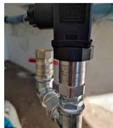
Misuratori di pressione RIELS Instruments RIB 100-H8T
