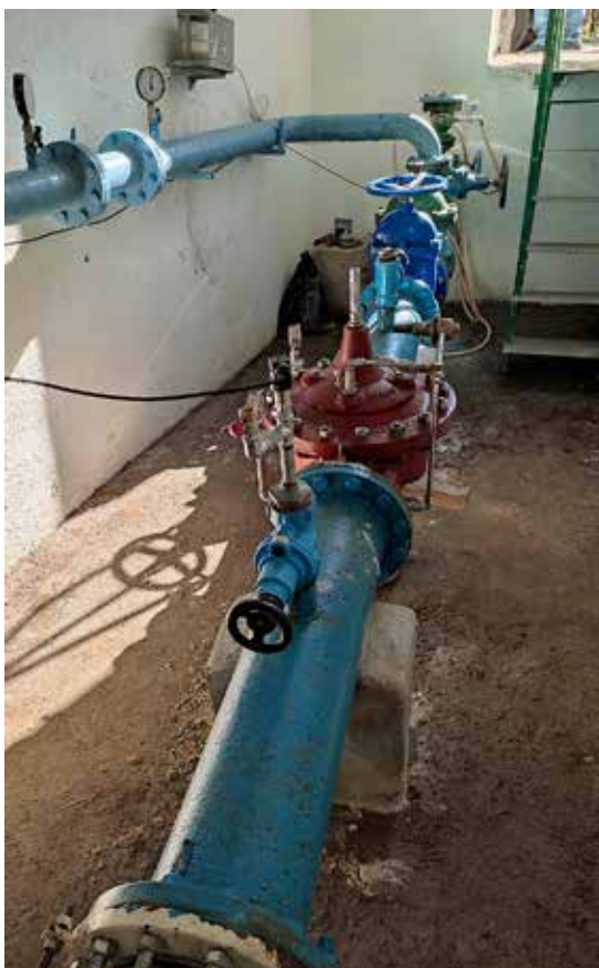
Partitore assemblato con: 1 sistema FCST - idrovalvola, pressostato e misuratore woltmann, 1 sistema FCSM - misu- ratori di portata ultrasuoni e di trasduttore di pressione
