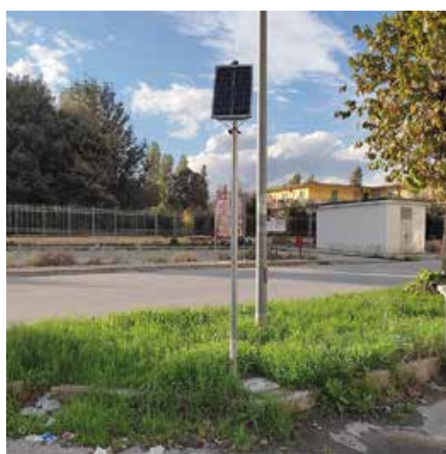
Installazione pannello fotovoltaico
