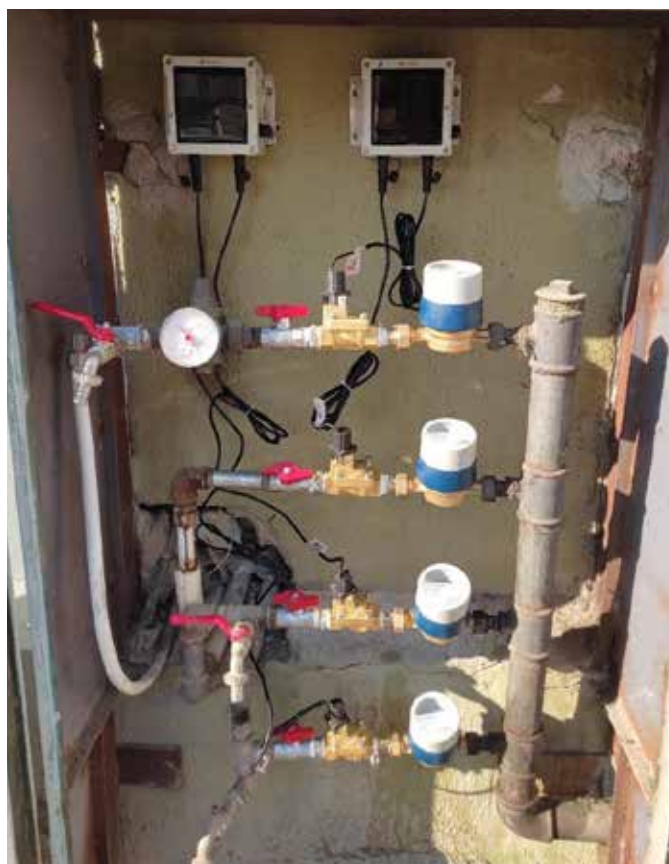
Installazione primo tipo di microFCS con elettrovalvola
