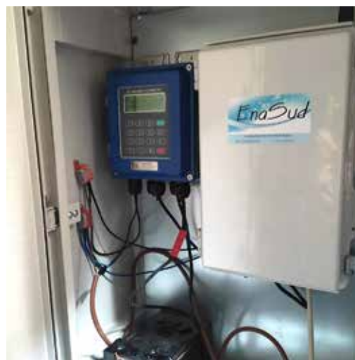
Misuratore FCM con batteria di alimentazione
