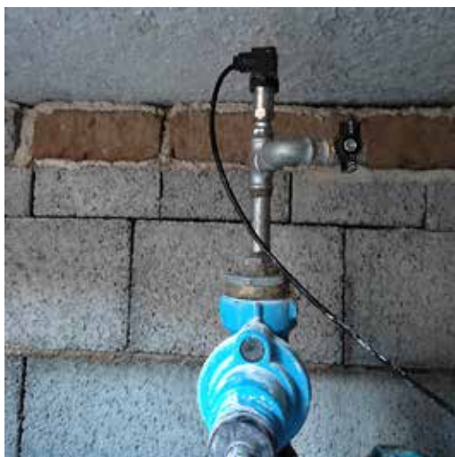
Misuratore di pressione RIELS Instruments RIB 100-H8T
