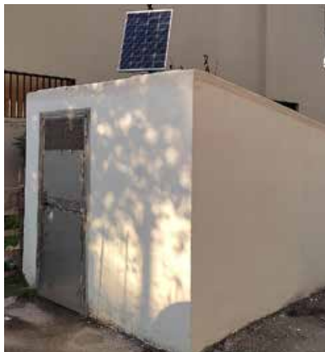
Vano di alloggiamento del Partitore
