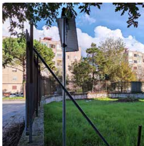
Installazione pannello fotovoltaico
