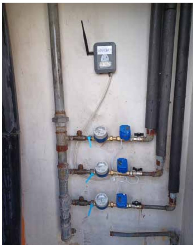
Installazione primo tipo di microFCS con valvol a sfera
