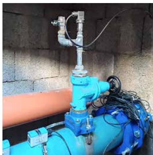
Misuratore di pressione RIELS Instruments RIB 100-H8T
